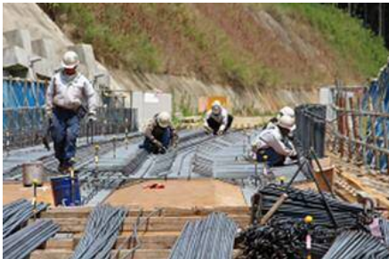
再び移動して、岩屋1号橋床版工事現場へ。こちらは一部配筋作業中。
