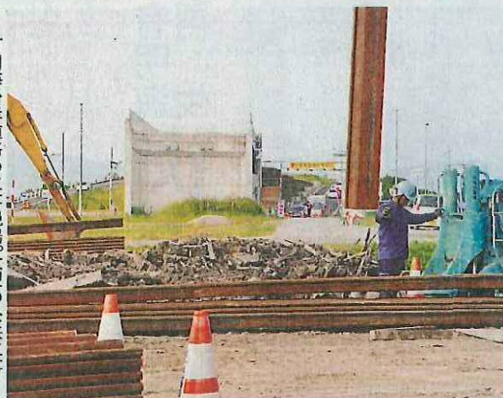
有明海沿岸道路の工事現場。大型の公共工事が続く中、報告書では人手不足などの課題や経営体質の強化のための対応をまとめた。
