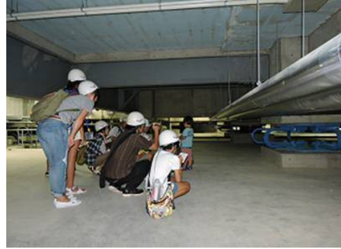
• 免震構造を見学中
