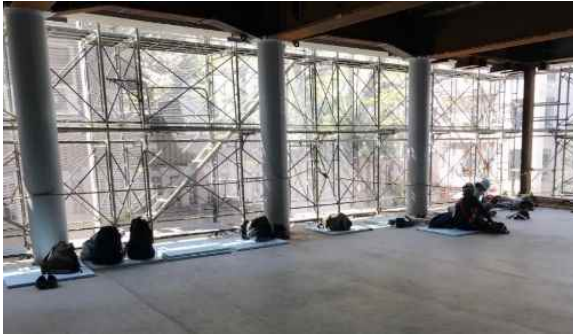
施工中の空きスペースをオープンエアの休憩所として利用
