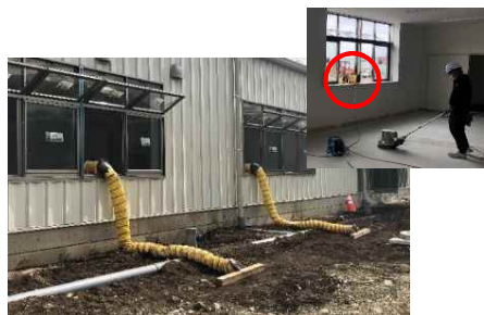
送風機を稼働し、埃を外部へ排出
