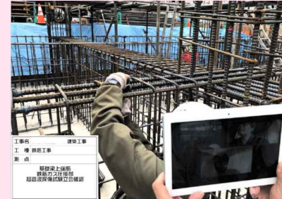
Webカメラを利用した遠隔検査
