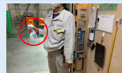
EVの操作盤等の消毒を徹底
