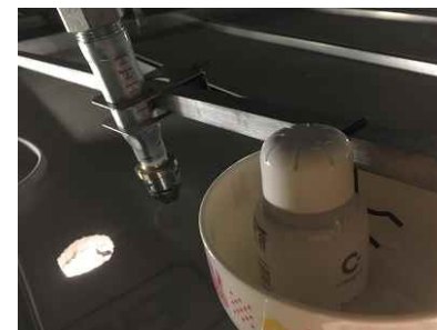
天井裏の作業は換気が難しいため、空間除菌剤を設置
