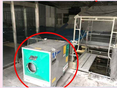
集塵機を設置し室内の換気を実施
