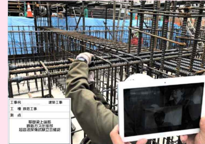
Webカメラを利用した遠隔検査
