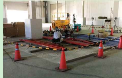
工事エリアの区画を設定して作業
