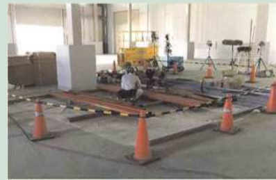
工事エリアの区画を設定して作業
