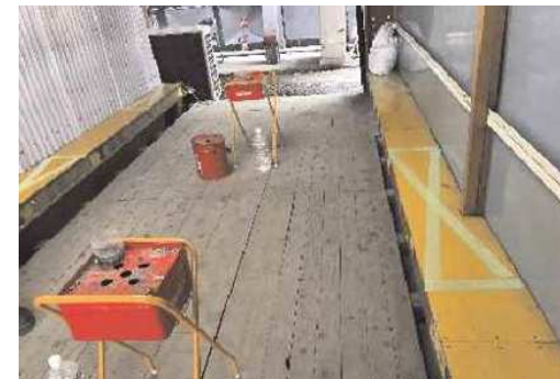
休憩所の壁を一部撤去し、通気性を確保
