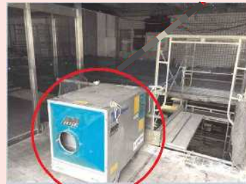
集塵機を設置し室内の換気を実施
