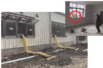
送風機を稼働し、埃を外部へ排出
