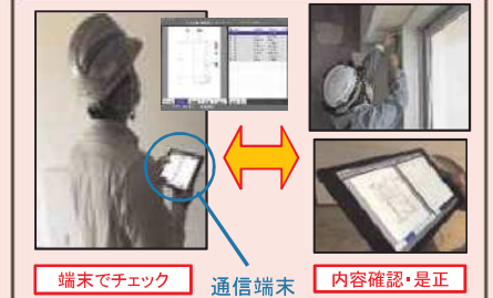
通信端末で内装仕上げの確認・是正
