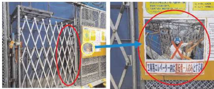
工事用エレベーターの定員を限定、ポスターを掲示
