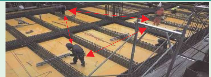
作業員の配置をブロック分けし密接した作業を回避
