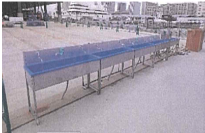
現場の手洗い場所の増設
