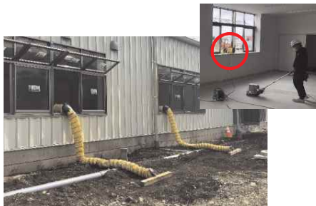
送風機を稼働し、埃を外部へ排出
