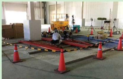
工事エリアの区画を設定して作業
