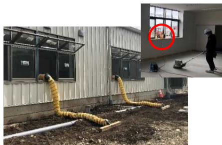
送風機を稼働し、埃を外部へ排出
