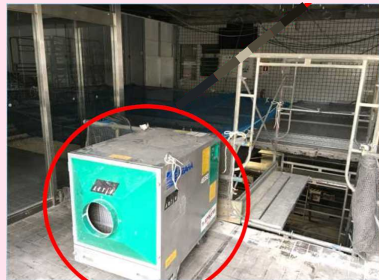
集塵機を設置し室内の換気を実施
