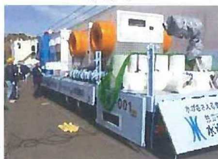
ポンプ車設置状況
