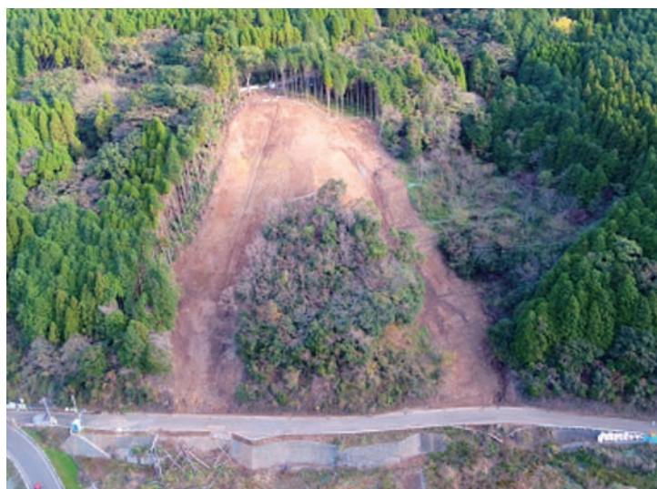
崩落土砂撤去完了
