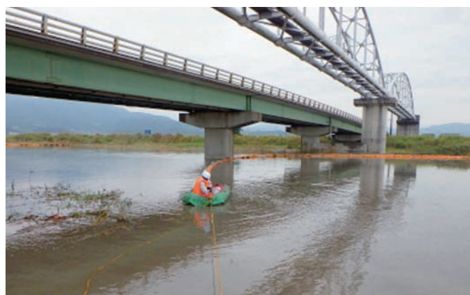
六角川にオイルフェンス設置
