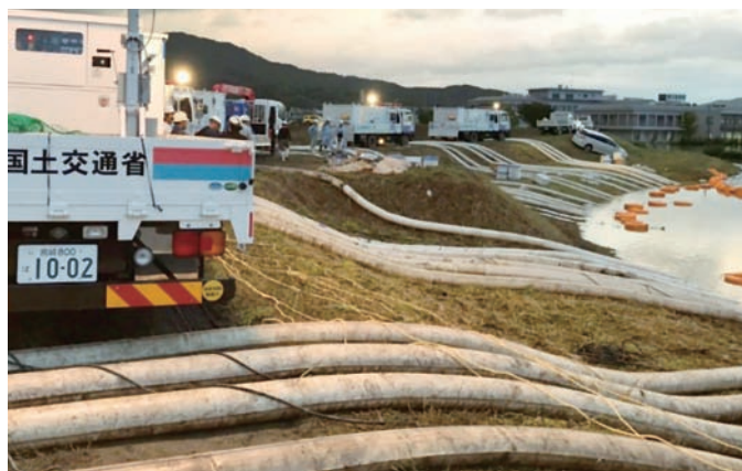
8月29日(木) 6:00頃 排水ポンプ車による排水活動状況
