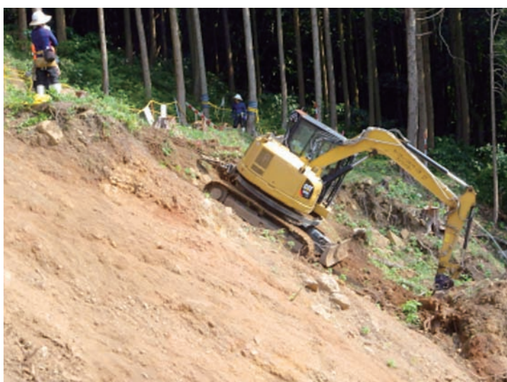
高所作業重機（無人） ほうらくど による崩落土撤去
