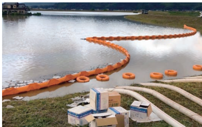
8月29日(木) 6:00頃 オイルフェンスの設置状況
