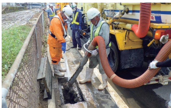
側溝に堆積した油などを回収
