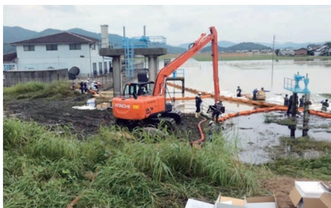
油吸着マット等による油回収
