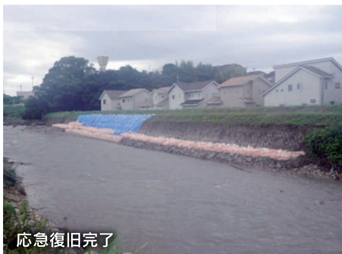
大型土のう設置状況
